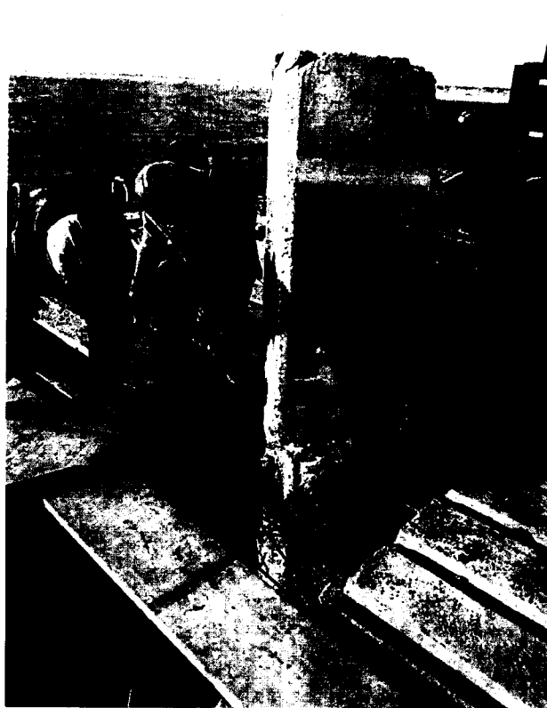
FOTO 04: Trabajos de unión viga-pilote
