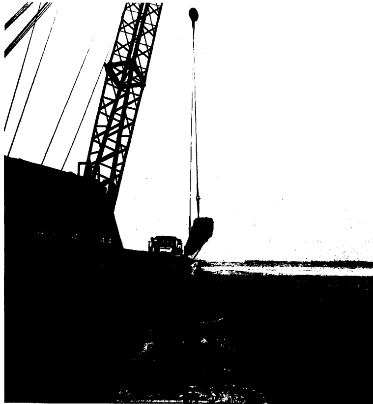
FOTO 03: Traslado de pilotes hacia la zona del cabezo
